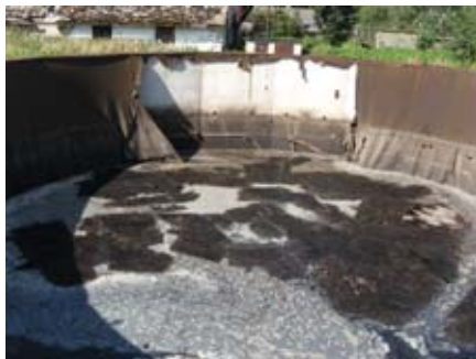
Nevhodné skladování závadných látek (zdroj ÚKZÚZ)
