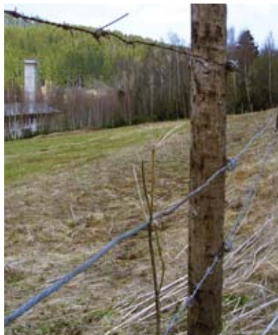
Příklad nevhodného použití ostnatého drátu k oplocení (Archiv SVS)
