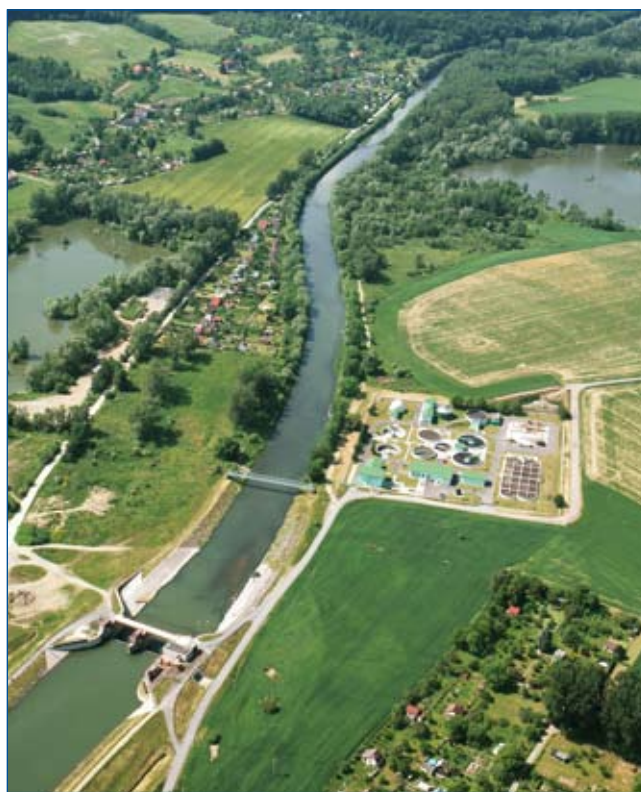
Bečva – ČOV – Hranice na Moravě
