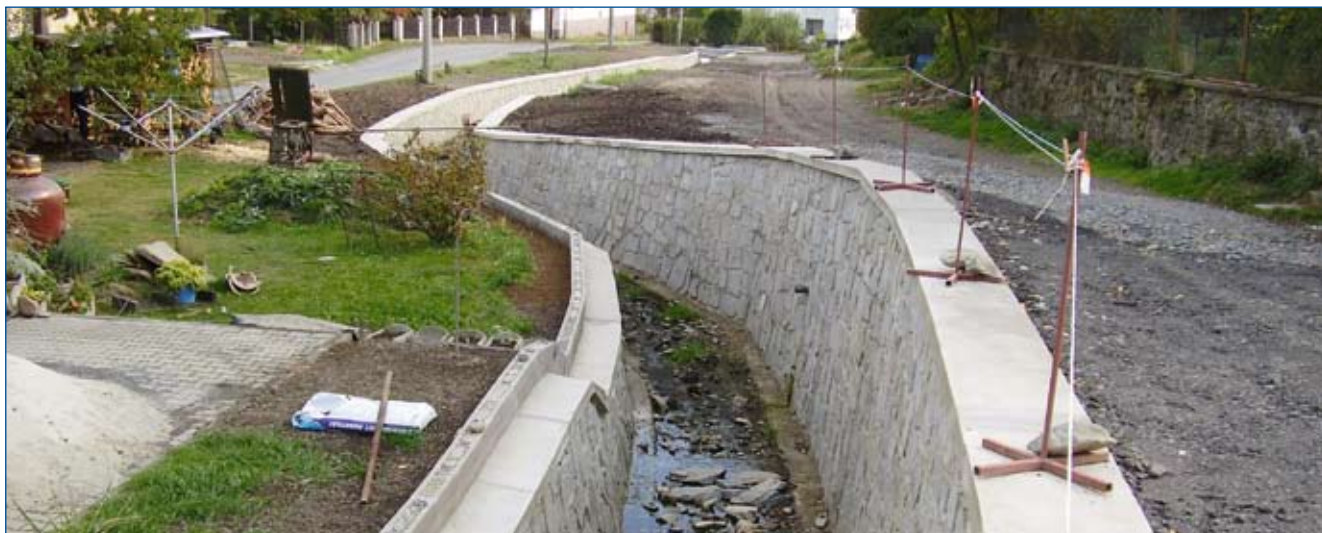
Úprava Liptaňského potoka
