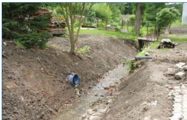
Česká Kamenice – prvotní zásah po povodních
