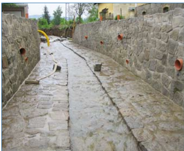
Zkapacitnění Žižňetického potoka – Nýrsko
