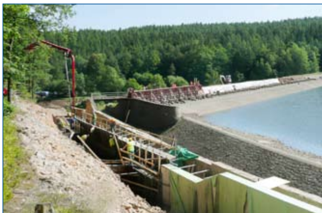
VD Záskařská – rekonstrukce
