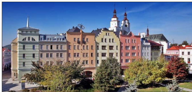
Revitalizace fasád na náměstí v Krnově
