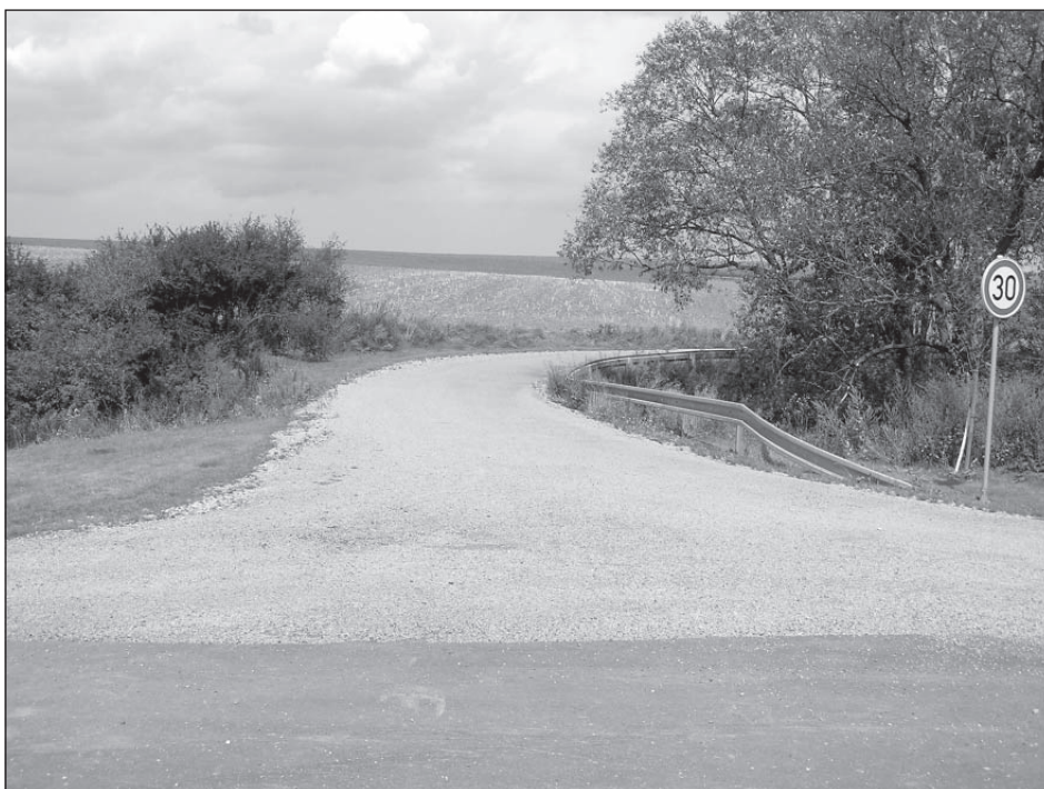
Celkový pohled na dokončené „přemostění strže“
