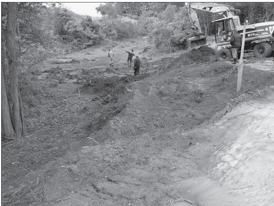
Zahájení výstavby úseku „přemostění strže“ v k.ú. Černikovice (PÚ Plzeň-sever)
