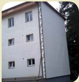
SK OEZ Testa Letohrad Zateplení SZ stěny správního objektu
