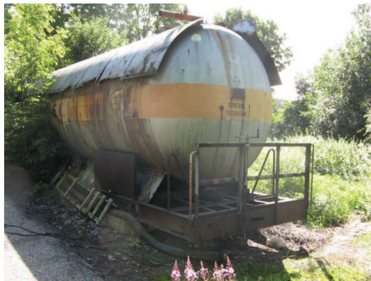
Nádrž DAM bez záchytné vany
